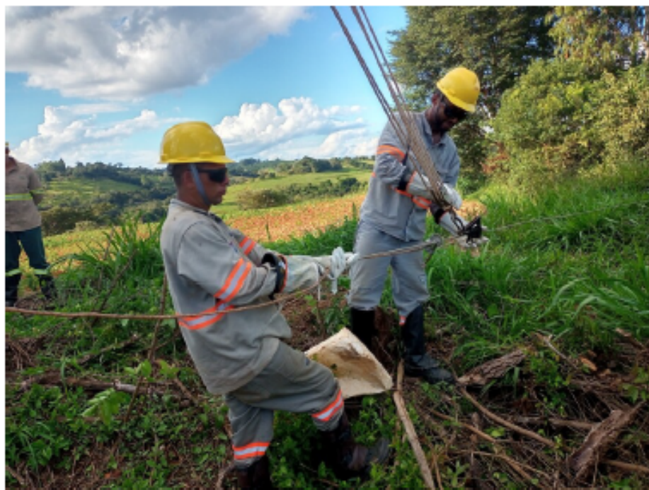
Figura 19: Betricistas instalando o moitão para elevar cabo rompido, utilizando luvas isolantes.
