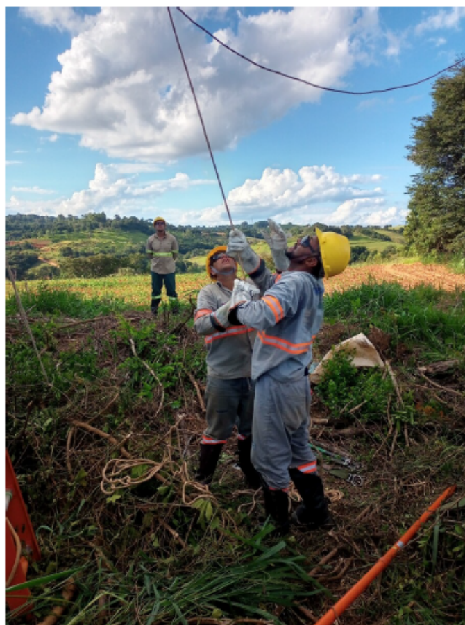
Figura 20: Eletricitistas elevando o cabo rompido
