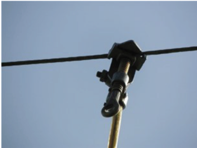
Figura 2: Grampo mal posicionado
