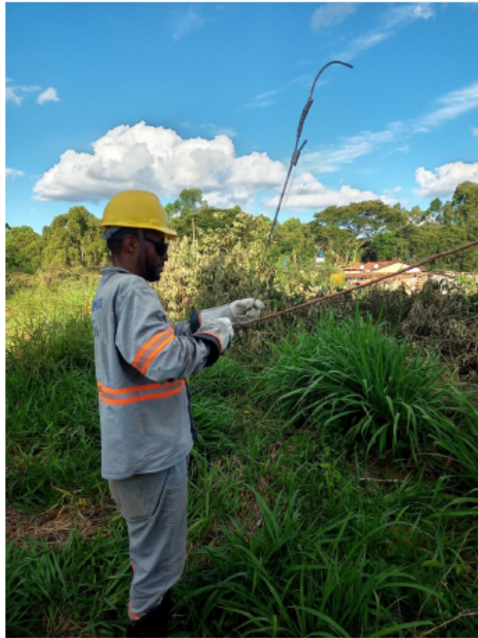
Figura 18: Elettricista instalando Grampo do segundo sela no neutro rompido, utilizando luvas isolantes.
