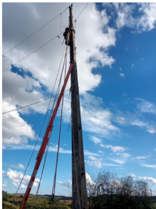
Figura 17: Poste aterrado com dois selas neutro, um do aterramento temporário e outro para a equipotencialização do eletricista
